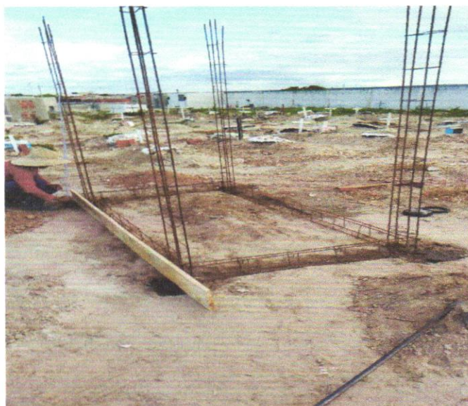
FOTO 01 - ESCAVAÇÃO MANUAL PARA BLOCO DE COROAMENTO OU SAPATA (INCLUINDO ESCAVAÇÃO PARA COLOCAÇÃO DE FÔRMAS). AF_01/2024
