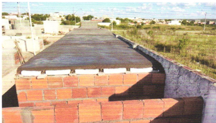
FOTO 04 - CONCRETAGEM DE VIGAS E LAJES, FCK=25 MPA, PARA QUALQUER TIPO DE LAJE COM BALDES EM EDIFICAÇÃO TÉRREA - LANÇAMENTO, ADENSAMENTO E ACABAMENTO. AF_02/2022
